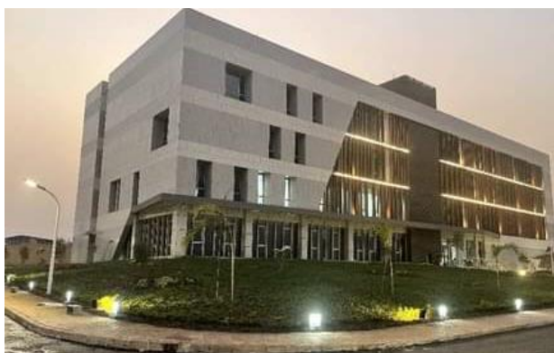
Vue de l'édifice
